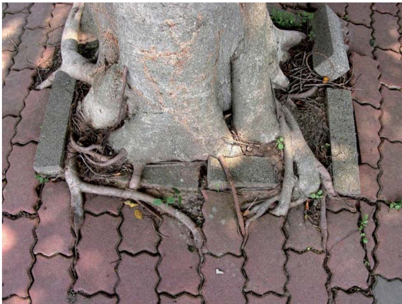
圖 2. 根系遇縫隙就鑽入
