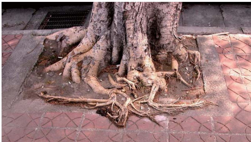
圖 8. 菩提樹地表根系常盤踞於鋪面
